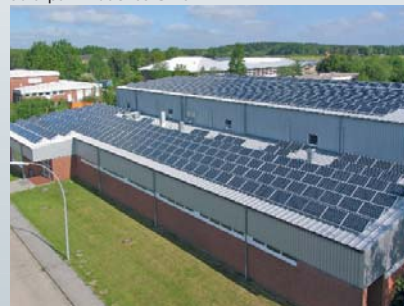
Solarpark Rodenäs GmbH
